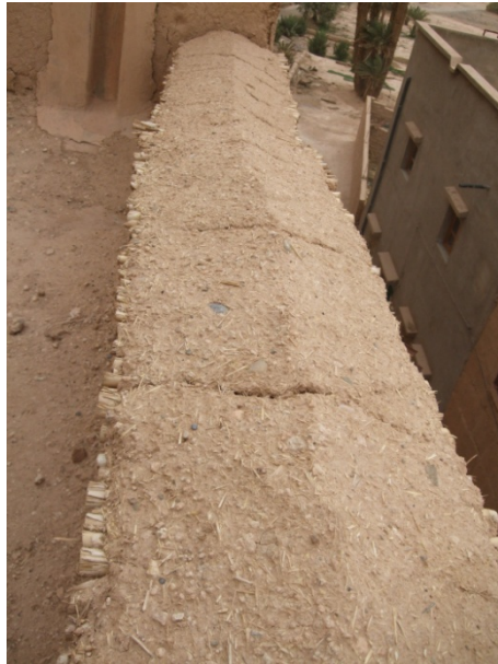
Estat actual de la rehabilitació del coronament de la muralla.
