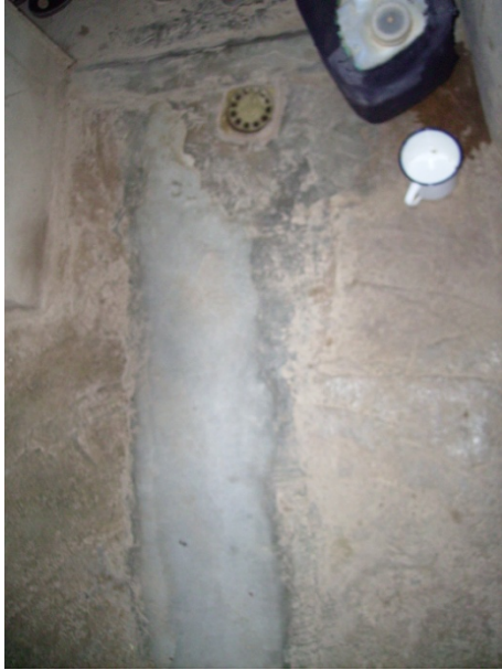
Connexions a la xarxa de sanejament fetes per els usuaris.
