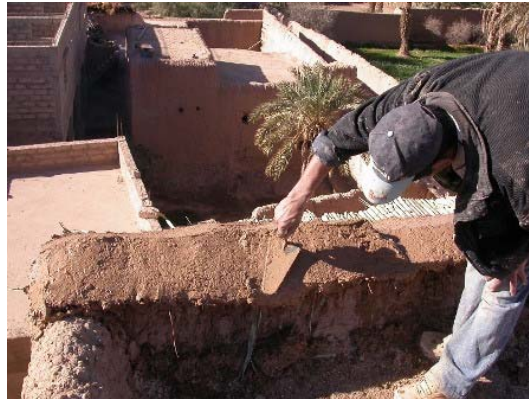
Execució del coronament del mur.
